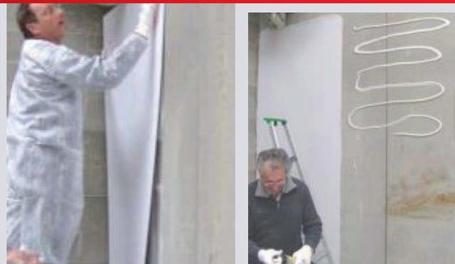
Mise en œuvre des plaques en respectant les alignements et les joints de dilatation, puis **maroufler** depuis le centre jusque sur les cotés. **Poursuite de la Pose** en reproduisant les étapes.
