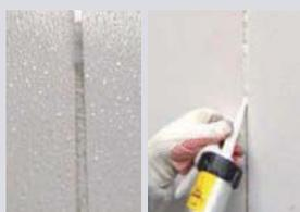
**option 1 :** Mise en œuvre du Joint d'Étanchéité Monocomposant Hydewa. **Attention :** Toujours respecter les joints de dilatation ! Se reporter au Guide de Pose.
