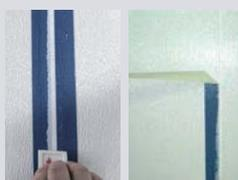
**option 3 :** Mise en œuvre d'un profilé PVC monobloc. Le profilé s'insère sous la première plaque collée dès sa mise en œuvre, ensuite coller la plaque suivante. Attention toujours respecter les joints de dilatation.
