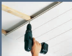
Pose sur ossature bois
