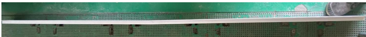
Photographie 11 : Déformée persistante au centre du profilé de supportage après essai (vue de profil)
