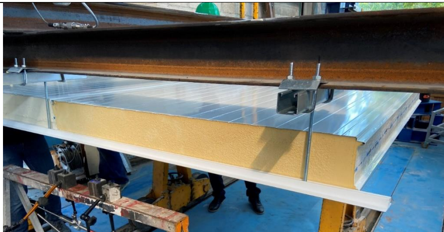
Photographie 2 : Mise en place des panneaux sandwich
