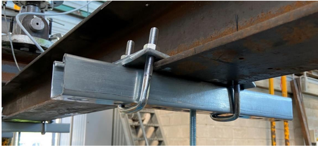
Photographie 1 : Positionnement des fixations et suspentes de levage
